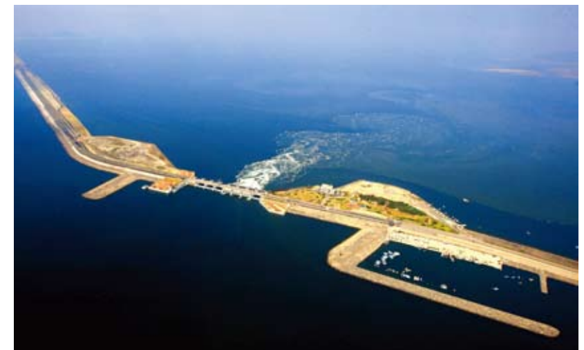
Saemangeum Seawall (terkenal sebagai tembok laut buatan manusia terpanjang di dunia) saat ini sedang dibangun sebagai pusat pengembangan energi hijau.
