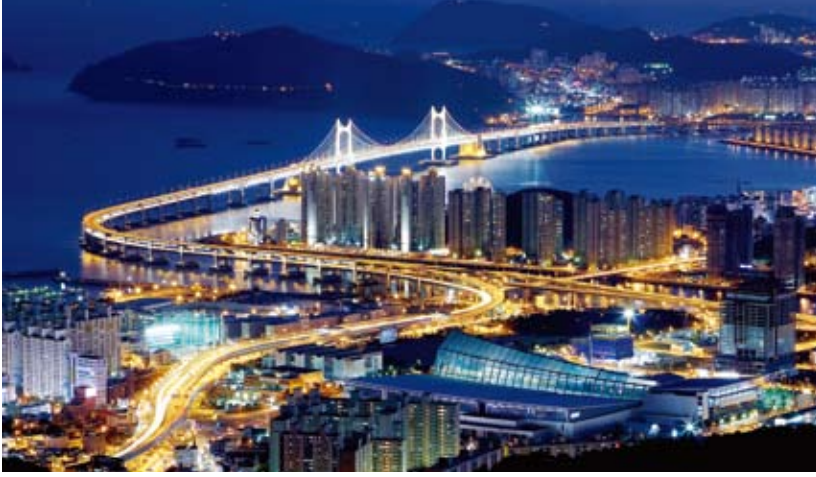
Gwangan Köprüsü, Busan Haeundae-gu'da bir asma köprüdür. 7.42 km uzunluğundaki bu yapı, Kore'nin ilk iki katlı deniz köprüsüdür.
