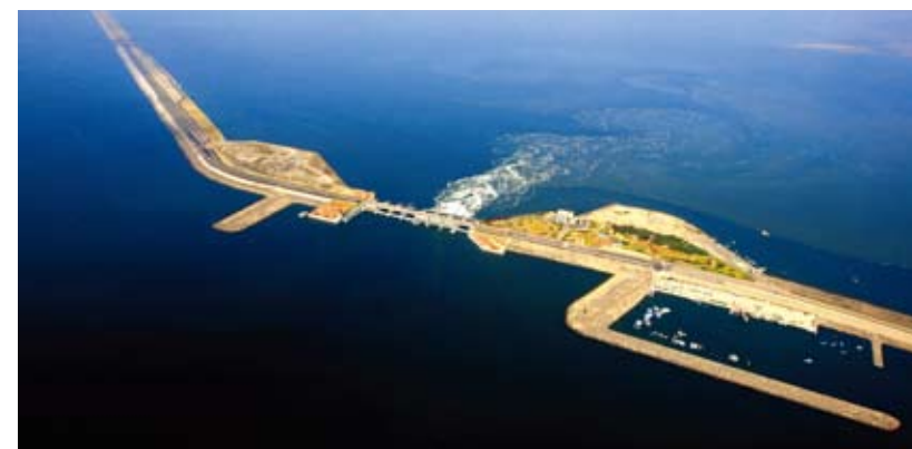
Строительство центра экологически чистой энергетики – дамбы Сэмангым.
